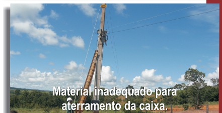
inspeção para medição de aterramento posto transformador JT-21 (334225).
