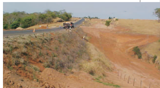
Serviços executados. Coberta a erosão de montante. (16/09/08).
